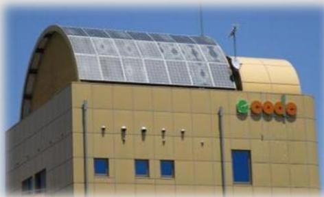
本部ビルの屋上に、太陽光パネルを設置し発電を行っています。発電した電力は即時使用し、余剰分を電気事業者へ売電しています。
